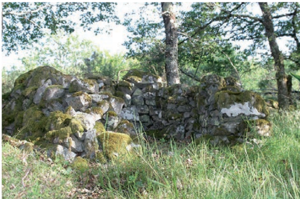
Cabane de berger (ruine de Tempaniergues)
