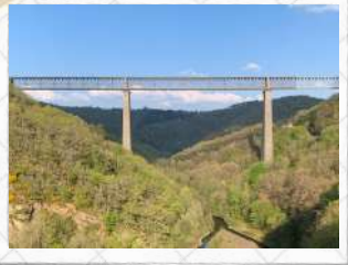
Viaduc des Fades Sauret-Besserve
