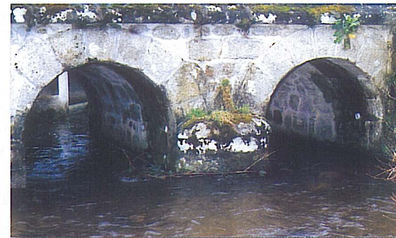
Photo : Alexandre BORDERE - Pont de Comiac
